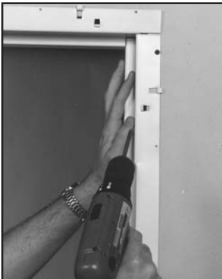
5 Aplique los sujetadores empezando por la parte superior del largueros de bisagra.
