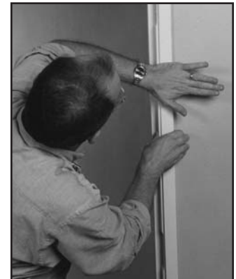
8 Deslice el chambranas del largueros lateral en el esquinero. Alinee con los sujetadores del largueros y encaje a presión.
