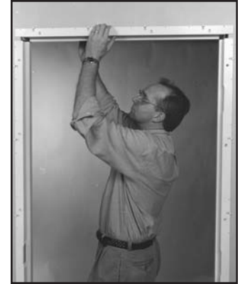
4 Hale hacia abajo el cabezal. Fije bisagras y cuelgue la puerta.
