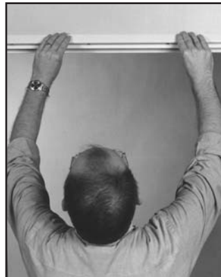
7 Encaje a presión el chambranas del cabezal.
