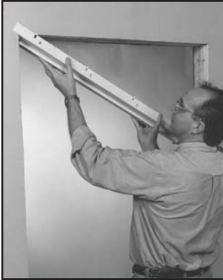
1 Fije el cabezal sobre la seccion de la pared.
